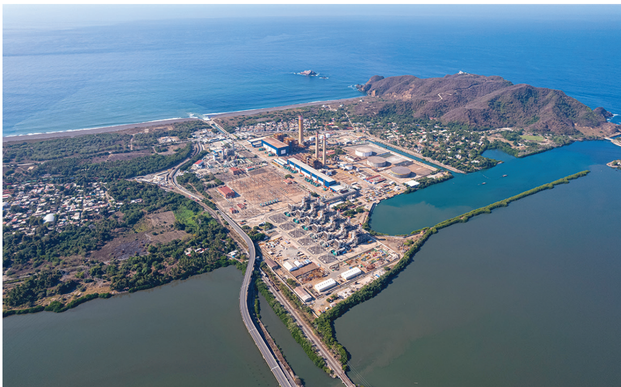
FIGURA P.3 Central termoeléctrica de ciclo combinado Manuel Álvarez Moreno, en Manzanillo, Colima. Este tipo de planta aprovecha el calor producido por la combustión de gas natural para generar electricidad de manera más eficiente.
